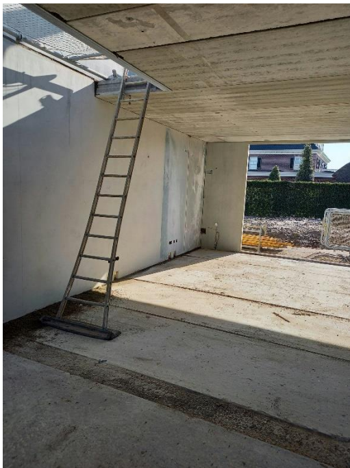
De wanden en de gevelelementen zijn uitgevoerd in geopolymeerbeton. Voor de vloeren is nog wel cementbeton toegepast.
